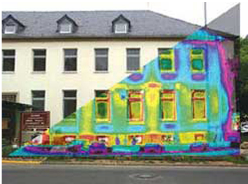
FIGURA 1.32 Una termografía de parte de un edificio muestra las variaciones de temperatura, e indica dónde es más intensa la transferencia de calor al exterior. Las ventanas son una de las principales regiones de transferencia de calor al exterior de las viviendas (créditos: Ejército de los EE. UU.).
