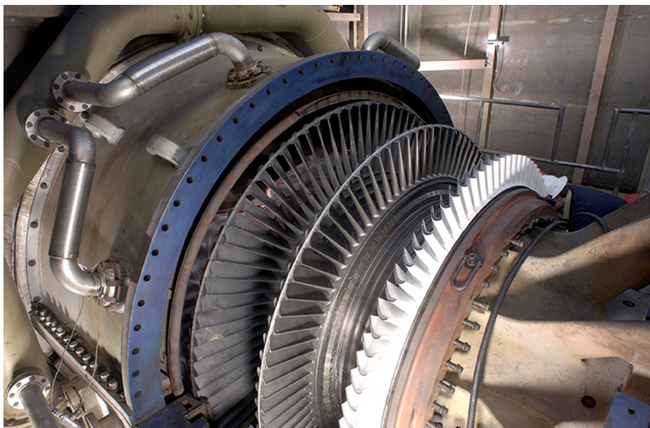
FIGURA 13.31 Turbina/generador de vapor. El vapor producido por la combustión del carbón impacta en las aspas de la turbina, haciendo girar el eje, que está conectado al generador.
